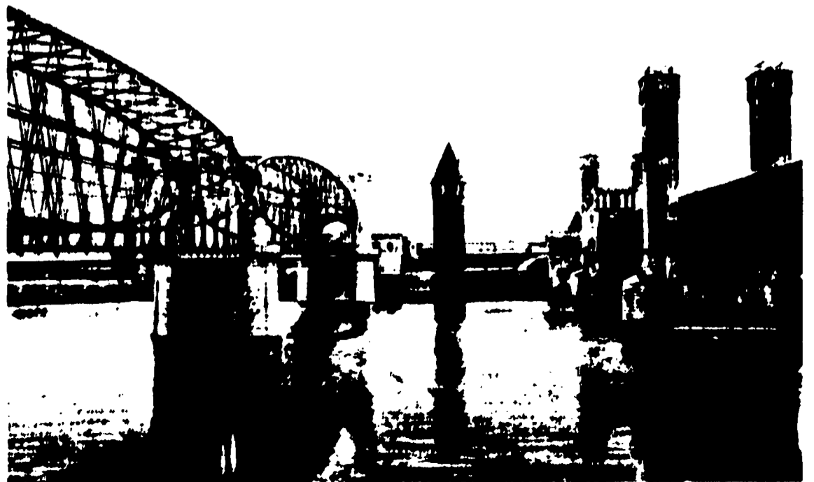
Brücken über die Nogat in Marienburg, hinten der Buttermilchturm.
